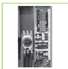
Panou de control și siguranță automată
